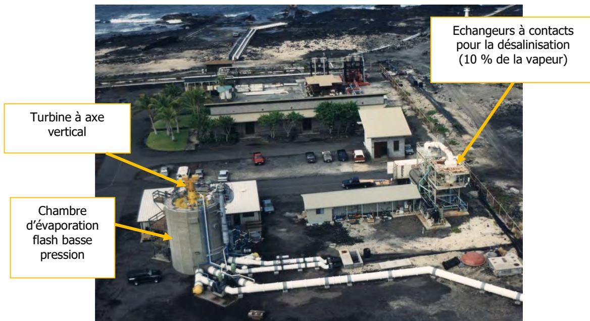
Figure 40 : centrale ETM en cycle ouvert à Hawaii. Source : Luis Vega, NELHA.
