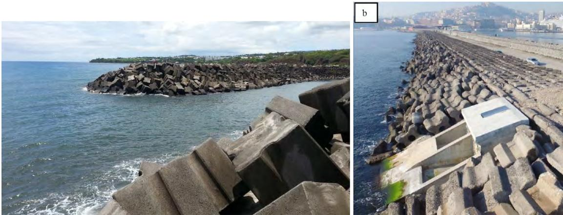
Figure 126 : digues en Blocs Cubiques Rainurés du port de Sainte-Marie (Conservatoire du Littoral) et système houlomoteur ajouté sur la digue du port de Naples (Contestabile et al. 2016)
