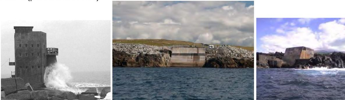
Figure 110 : systèmes à colonne d'eau oscillante : Shanwei, Province de Guangdong, Chine, 100 kW – île d'Islay, Ecosse, 500 kW (LIMPET) - île Pico, archipel des Açores, Portugal, 700 kW
