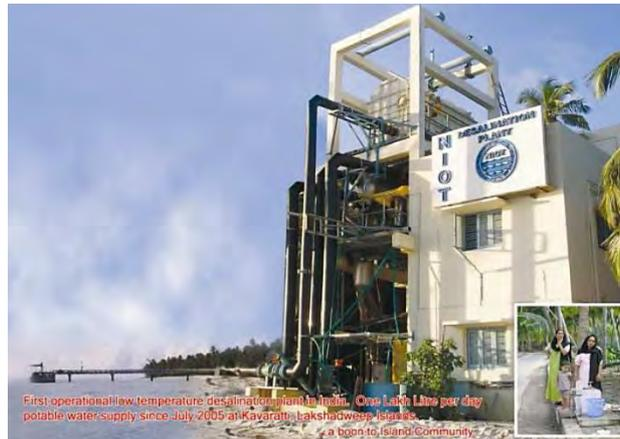
*Figure 44 : centrale thermique de désalinisation à basse température de Kavaratti, la capitale de l'archipel de Lakshadweep, au large des côtes sud-ouest de l'Inde. Source : NIOT.*
