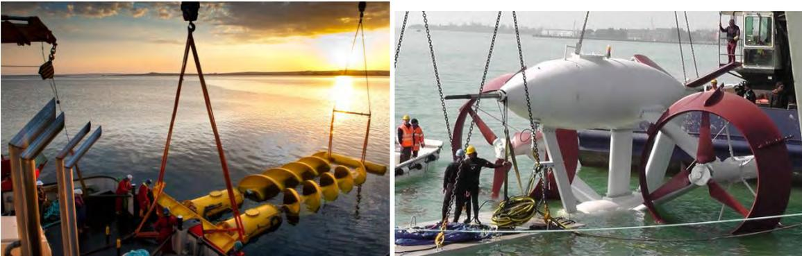
Figure 26 : hydrolienne Flumill (Norvège) et hydrolienne à aile portante SeaPower de 100 kW (Italie)
