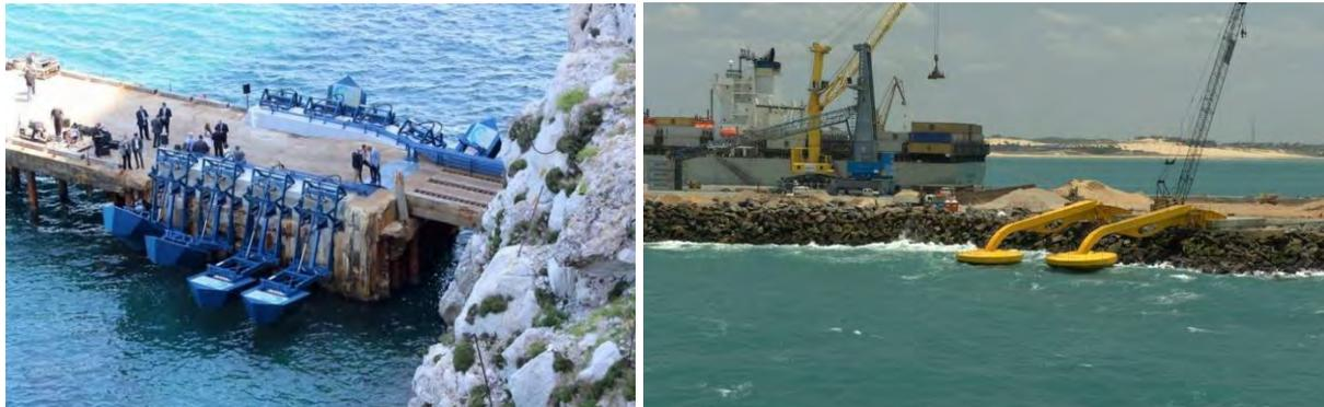
Figure 112 : système "Eco wave power" de 10 kW au port de Gibraltar (Espagne) à gauche, à droite autre système du même type de 50 kW installé en 2012 par l'Université de Rio de Janeiro au port de Pecem (Brésil)
