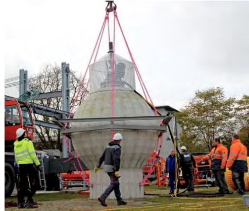
Figure 62 : projet de STEP marine Stensea, concept et prototype échelle 1/10<sup>e</sup>. Source : Fraunhofer IWES
