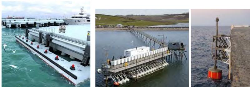
Figure 128 : dispositifs houlomoteurs Drakoo, Wave Star et Sinn Power.
