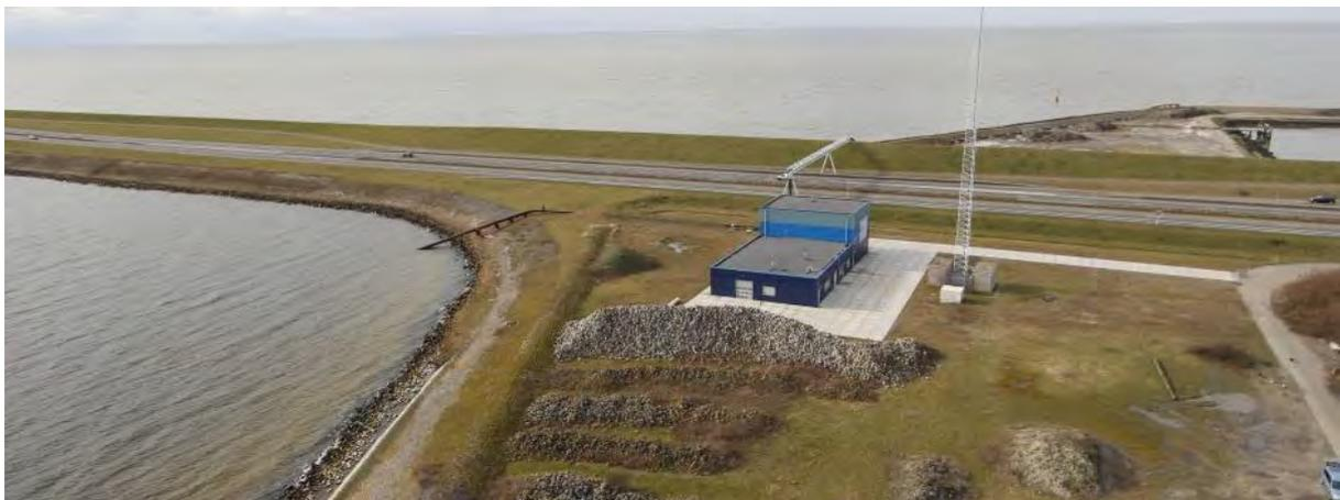
Figure 57 : Centrale pilote (50 kW) d'énergie osmotique par électrodialyse inverse aux Pays-Bas. Source : REDStack
