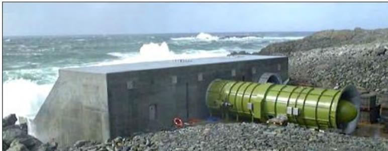
Système OWC onshore (centrale pilote de l'île d'Islay en Ecosse dénommée « LIMPET ». D'une puissance de 500 kW, elle alimente le réseau électrique de l'île depuis l'an 2000.
