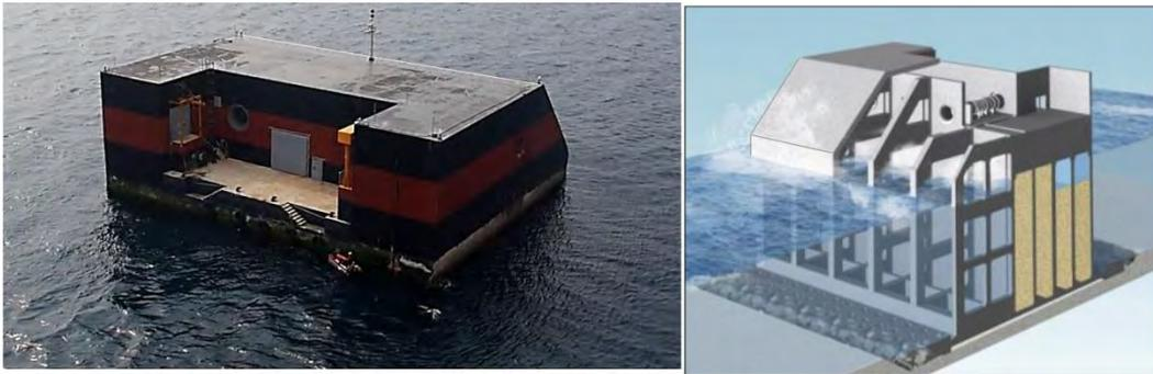
Système OWC posé sur le fond marin (centrale pilote de Yongsoo sur l'île de Jeju en Corée du Sud, développée par le Korea Research Institute of Ships & Ocean Engineering (KRISO). D'une puissance de 500 kW, elle alimente le réseau électrique de l'île depuis juin 2016.
